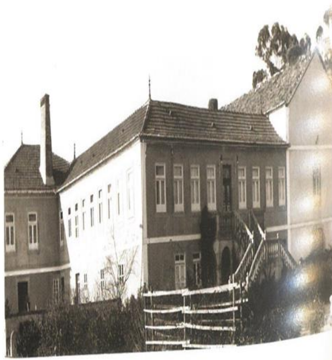
Residência de Frederico Capelo Manzarra Franco (1935)
